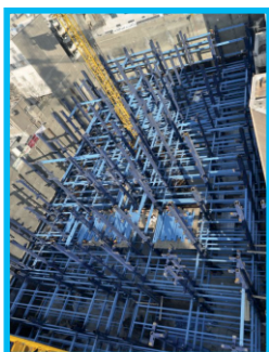
ساختمان مرکزی بنیاد شهید
