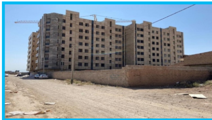
پروژه مس سرچشمه
